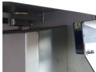
När man lämnar maskinen stängs den automatiskt av.
